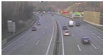
Autobahn A2, Graz-Ost – Laßnitzhöhe Mooskirchen – Graz-Ost
